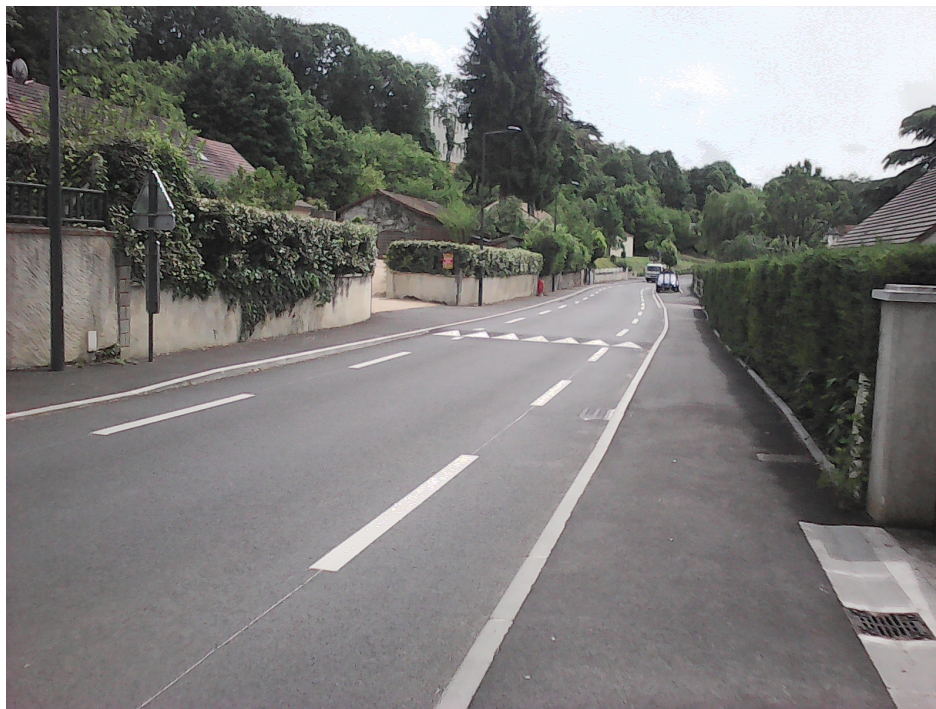
FIGURE 3.6 – Photographie de la rue de type "chaucidou" à La Membrolle-sur-Choisille (Rue du Moulin Millon)
