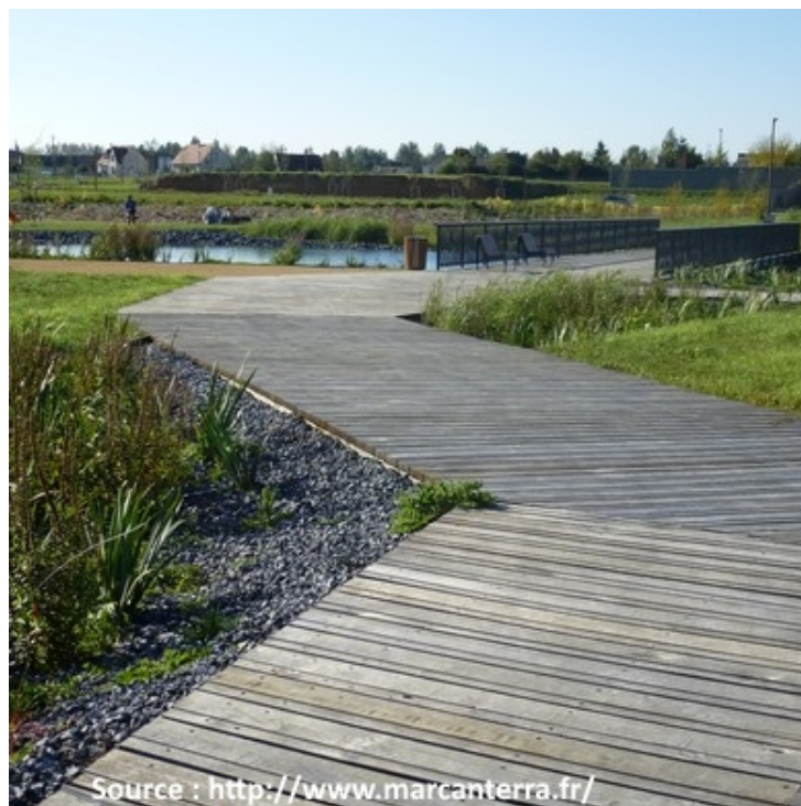
FIGURE 3.3 – Photographie d'un exemple de cheminement de platelage bois à Bailleuil-sur-Thérain (60)
